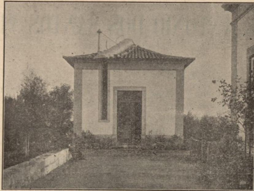
Casa meridiana onde está instalado o aparelho portatil de Repsold & Shöne
