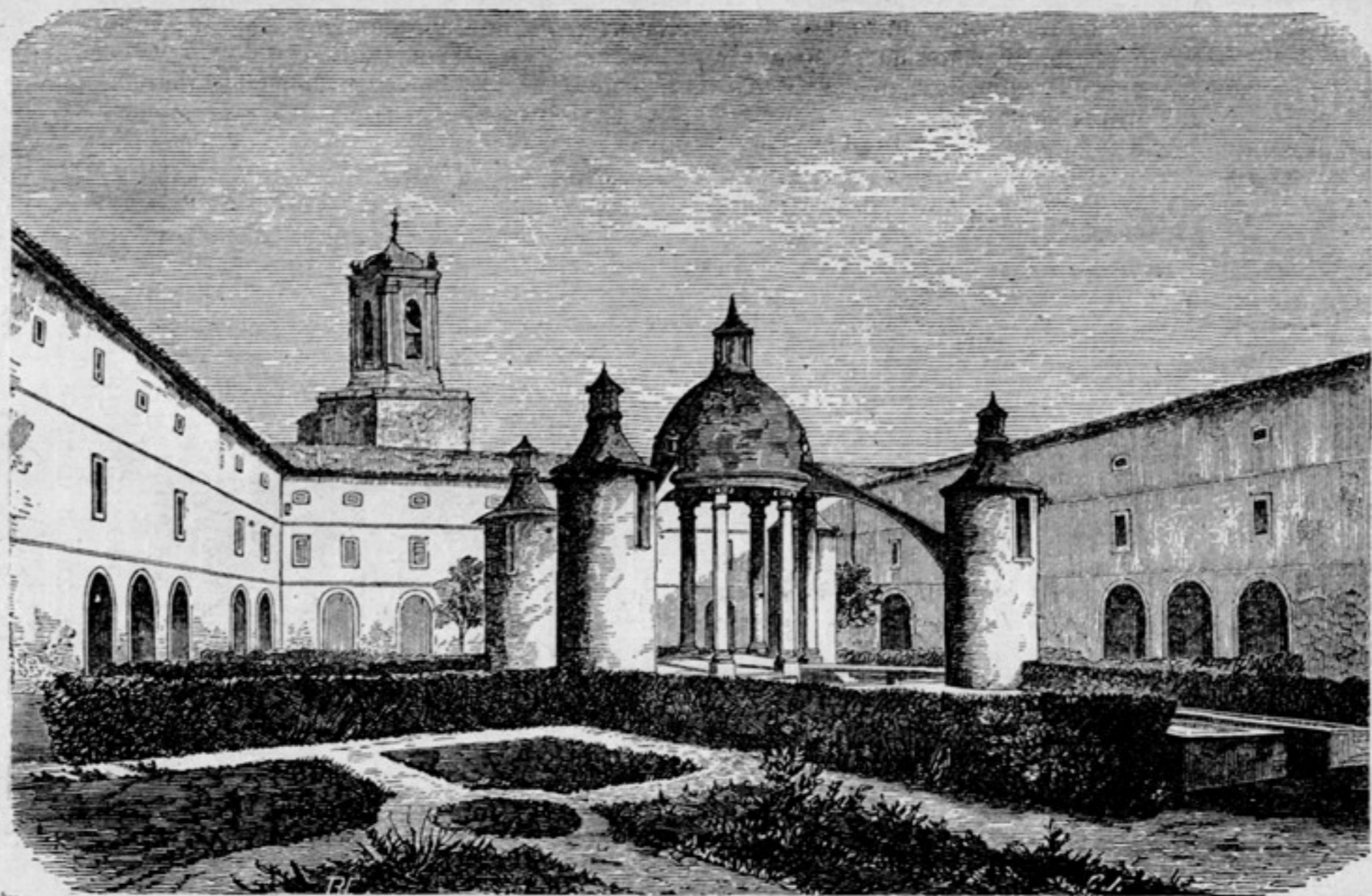
Jardim da Manga e lanços do Mosteiro que o circundavam, nos quais foram instalados os serviços da Administração Geral dos Correios.
