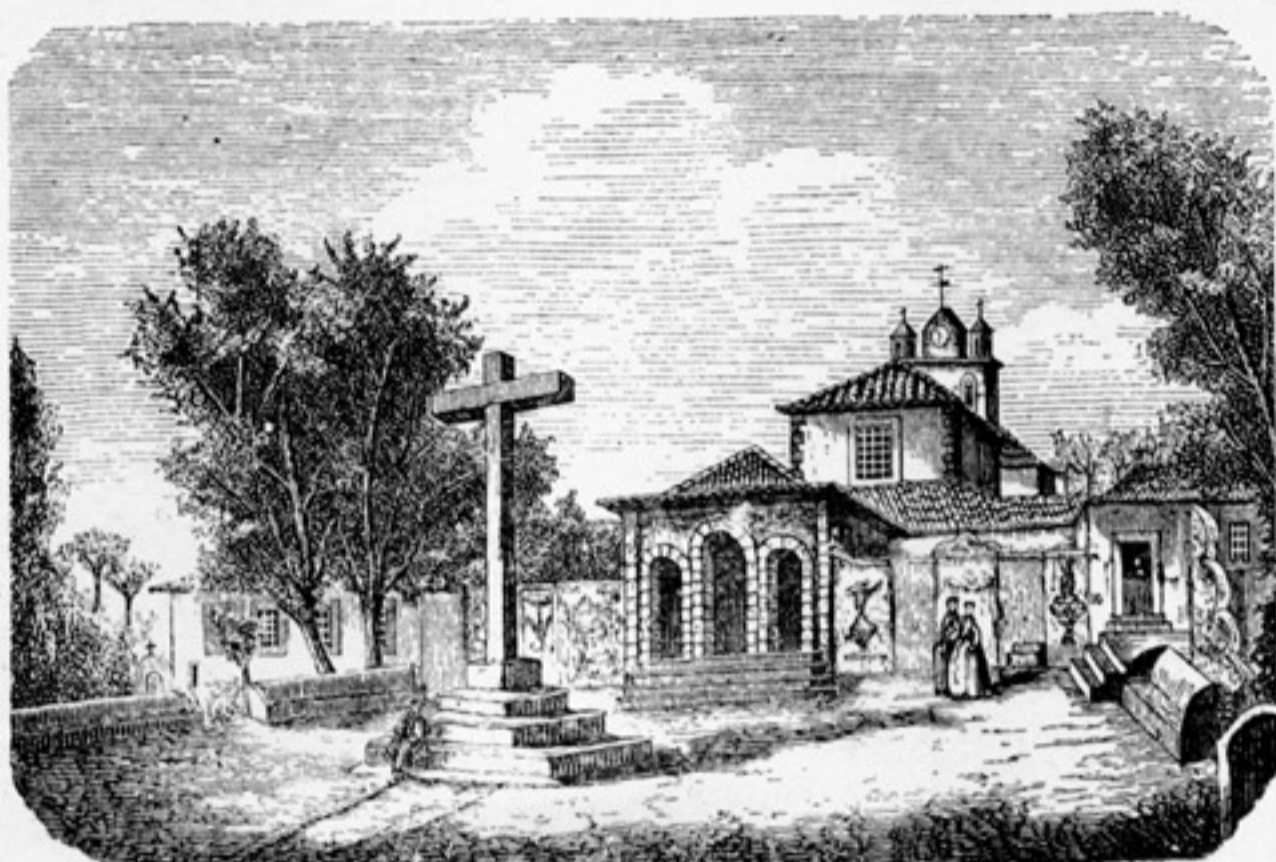
Mosteiro do Buçaco, tal como era antes da demolição parcial
