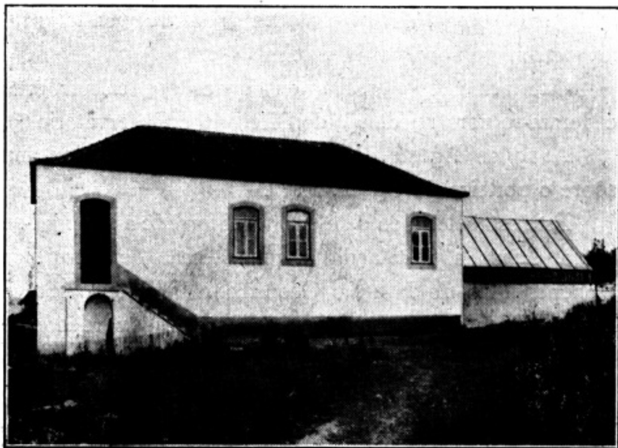
Instalações de Astrofísica (Cumiada) Dependências do espectroeliógrafo (à esquerda) e do celostato (à direita)
