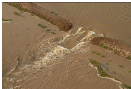
Fot. 3 - Implosão do dique irregular na Lagoa Feia em Campos dos Goytacazes (RJ), Brasil em 2008 (Fonte: M. B. Lessa, Dezembro de 2008).
