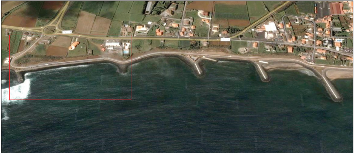
Fig. 2 - Porto da Praia da Vitória: Zona entre os esporões 1 e 2 (onde se localiza a secção D) (Fonte: Google Earth). Fig. 2 - Praia da Vitória harbour: Area between groins 1 and 2 (where section D is located) (Source: Google Earth).
