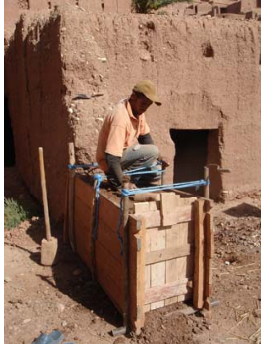
Fig. 3. Construcción de tapial (créditos: autora).
