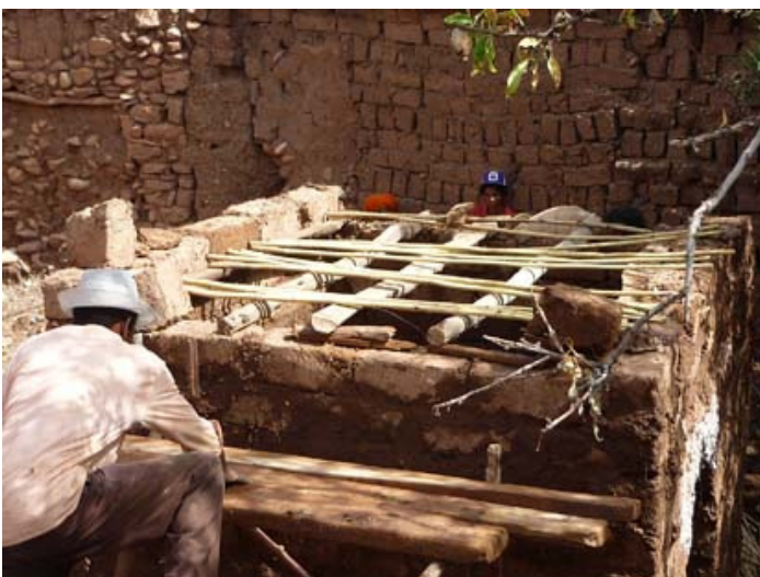
Fig. 8. Preparación de la cubierta (créditos: autora).
