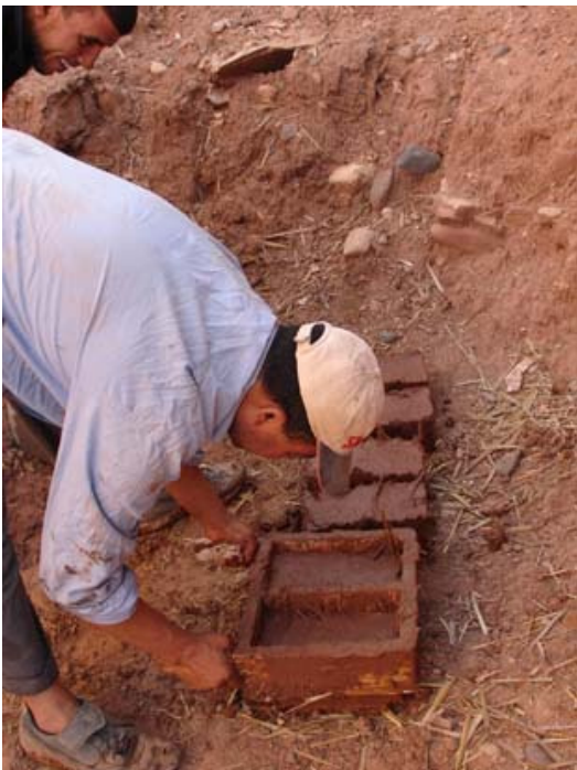
Fig. 4. Ejecución de ladrillos de adobe (créditos: autora).
