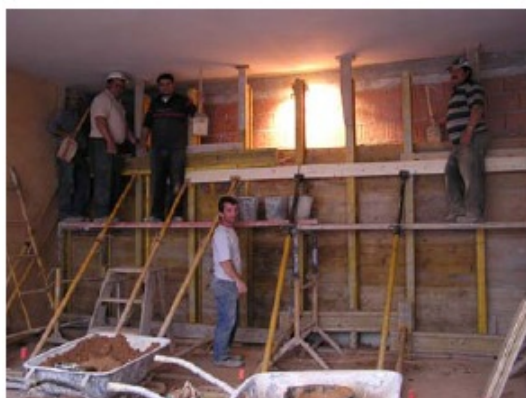
Fig.5 - Execução das paredes de taipa (Vera Schmidberger – 2008)
