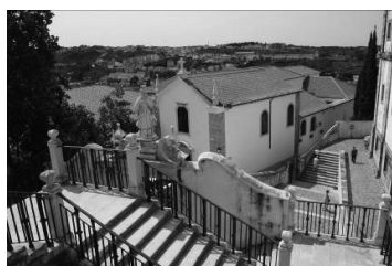
Escadas de Minerva, Universidade de Coimbra.
