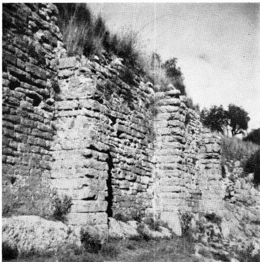
VII — Aspecto parcial das muralhas viradas para o lado do «Rio dos Mouros», com contrafortes colocados a intervalos regulares.
