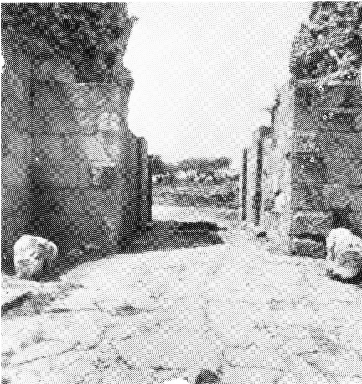
III — Aspecto exterior da porta principal do circuito de muralhas («Porta de Tomar»), vendo-se o lageado
