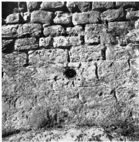
VIII — Pormenor da base da muralha do mesmo lado, para mostrar um dos tubos de drenagem das águas vindas dos terrenos do lado interno. O mesmo sistema foi usado no aqueduto que, de Alcabideque, trazia a água para Conimbrigã.
