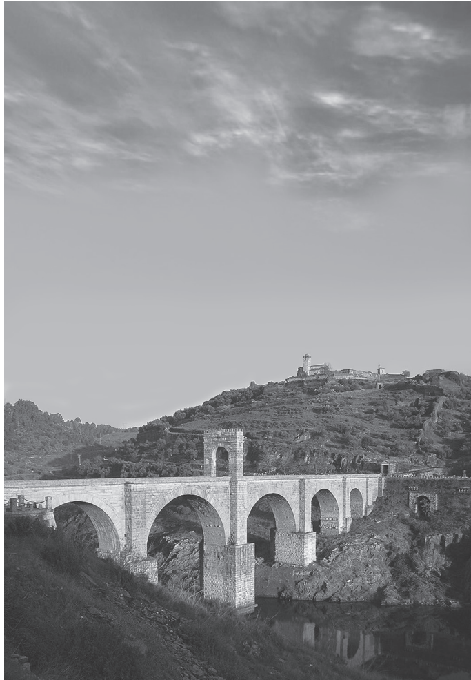
FIG. 8 – A ponte de Alcântara vista de jusante (foto VON DANTLA).
