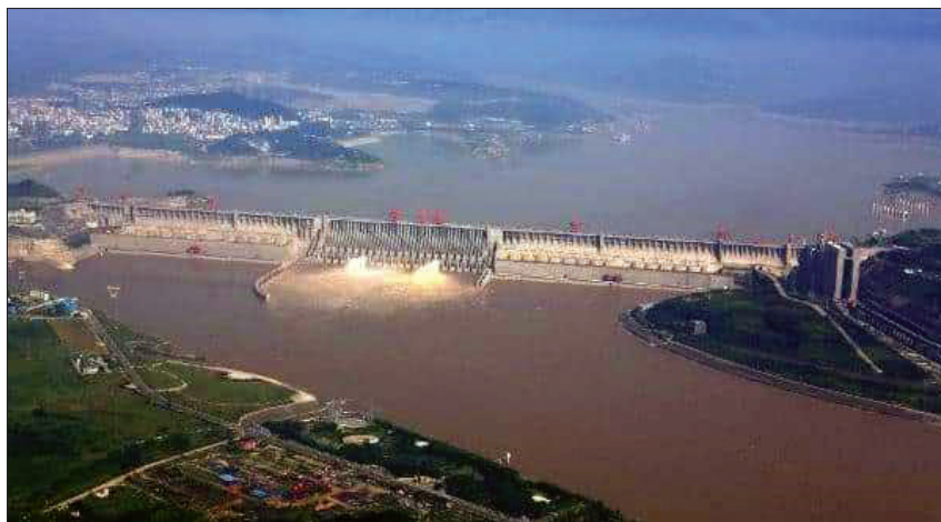
Fig. 91 - Central hidroelétrica das Três Gargantas (Fonte: [120]).
