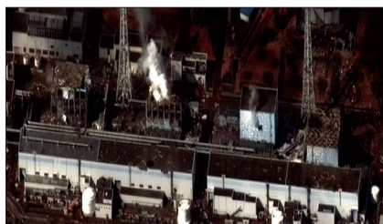
Fig. 86 - Imagem dos reatores danificados na central Fukushima I (Fonte: [104-A]).
