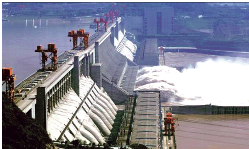
Fot. 2 - Maior barragem do Mundo na atualidade, com 39,3 \text{ km}^3 de capacidade: 'The Three Gorges Dam', China (Encyclopædia Britannica, 2018).
