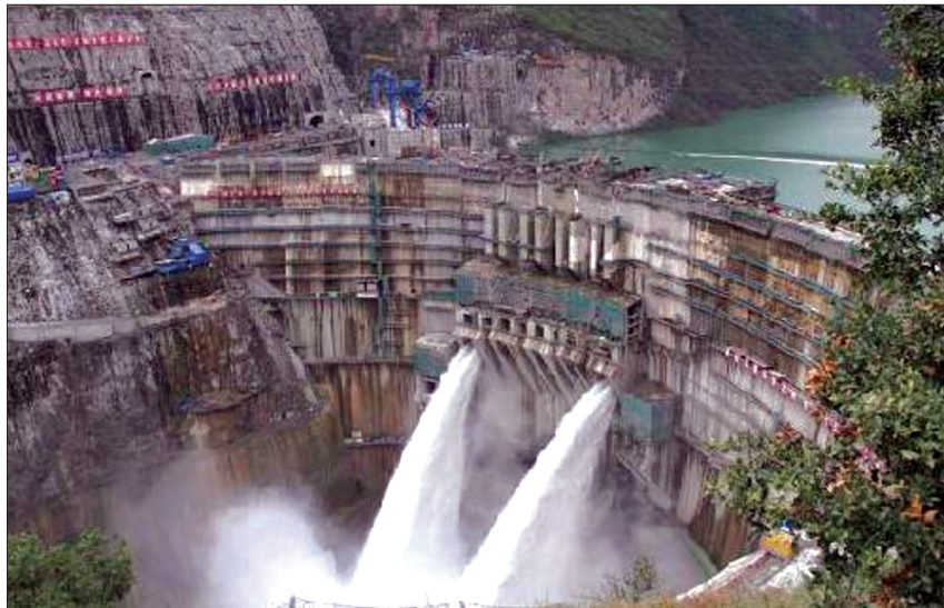
Fot. 3 - Barragem de arco mais alta do mundo na atualidade, com 305 m: Jinping-I, China ( http://en.powerchina.cn/2016-12/28/content_27870606.htm ).
