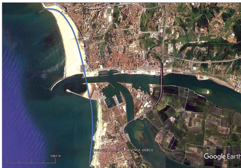
Fot. 25 - Molhes de proteção do porto e atuais configurações das praias da Figueira da Foz e da Gala. A linha azul identifica a posição aproximada da linha de costa (limites das praias) nos anos 60 do século passado, antes da construção dos molhes (Fonte: adaptada de Antunes do Carmo, 2018).
