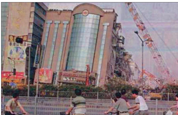
Fot. 21 - Colapso durante a construção do metro de Xangai, 2003 (Fonte: Gomes, 2012).
