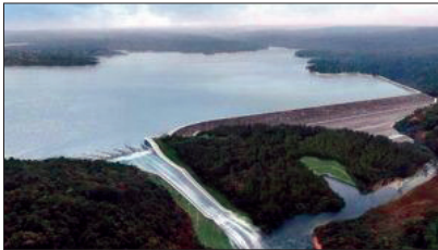
Fig. 87 - Barragem antes do colapso (Fonte: [105]).
