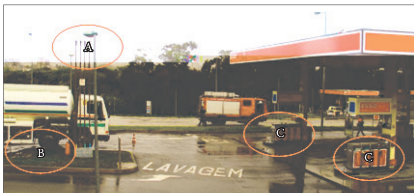
Fig. 10 - Um Posto de Combustível com as áreas de maior risco assinaladas com círculos: A) Tubagens de respiro dos tanques de combustível; B) Bocas de enchimento dos tanques; C) Ilhas com bombas para envelhecimento dos veículos (Fotografia de Salvador Almeida).
