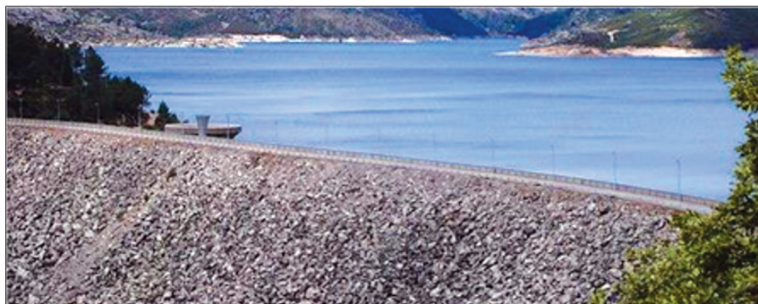
Fot. 5 - Barragem de enrocamento com cortina a montante (Paradela), no concelho de Montalegre, distrito de Vila Real (INRH, 2016).
