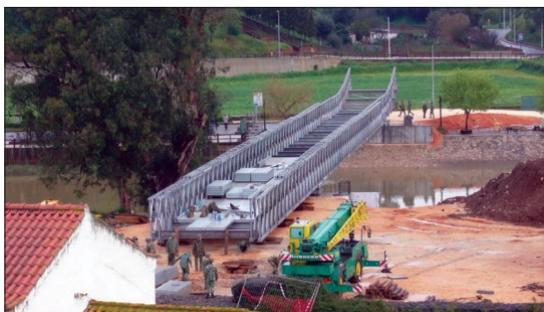
Fig. 11 - Apoio Militar - Transposição de cursos de água ou de vãos usando pontes militares
