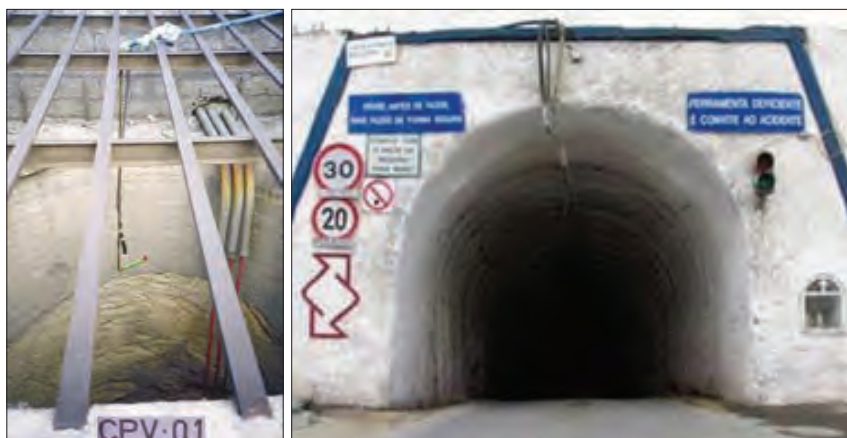
Fig. 43 - Poço CVP-01 (4) e rampa de Castro da Mina de Neves Corvo (Fonte: Revista Ingenium, n.º 119, 2010).
