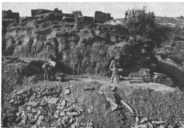
FIG. 3 — Trabalhos de escavação, em 1967, no Castelo da Lousa, começando a pôr-se a descoberto a rocha que foi cortada verticalmente para abertura de um fosso.
