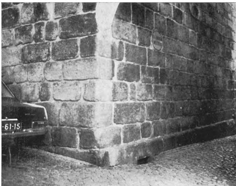
FIG. 14 — Base de la Torre que da acceso a Arcacova de Cima (Foto A. G. y B.)
