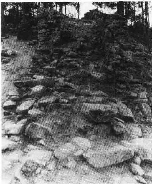
Foto 1 — Enchimento de pedras e saibro entre dois muros longitudinais da barragem.
