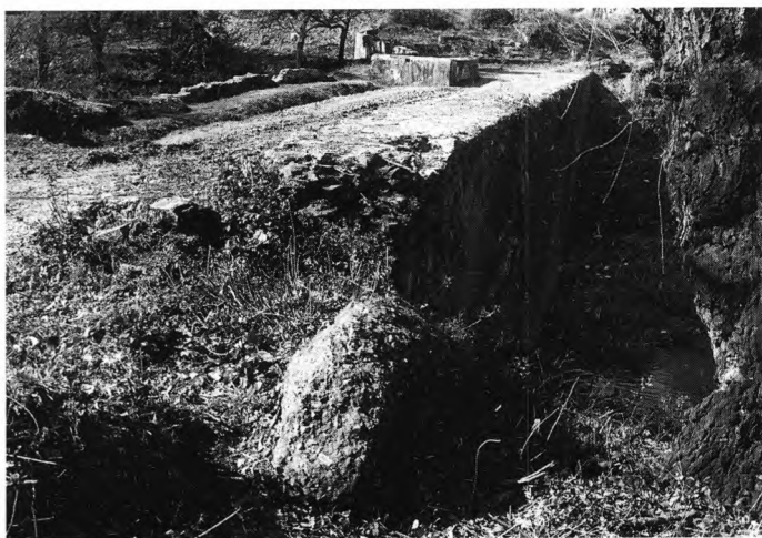
FOTO 28 – Barragem de Alferrarede (Abrantes). Vista do coroamento e do paramento de montante, obtida da margem esquerda. Nota-se, em primeiro plano, um bloco de opus signinum , que pertenceria à primitiva barragem romana
