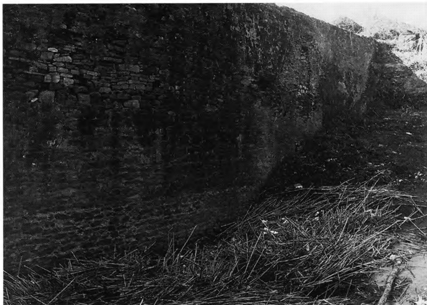
FOTO 29 – Barragem de Alferrarede (Abrantes). Vista do paramento de montante, notando-se, próximo do extremo da margem direita, restos de muro de opus signinum da primitiva barragem romana
