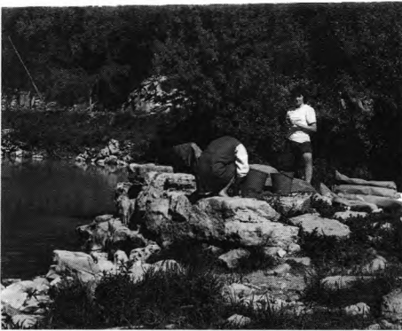
FOTO 6 – Pormenor de açude, em alvenaria, no lugar das Lapas.
