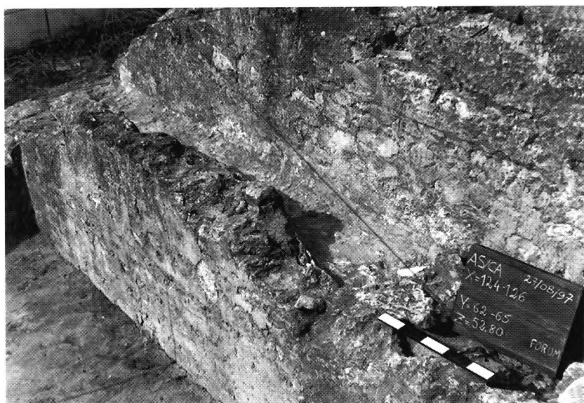
FOTO 10 - Conduta adossada a uma das paredes da cella em ábside
