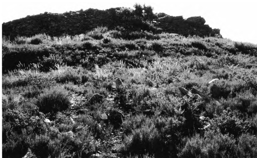
FOTO 2 - Castelo dos Mouros de Vale de Égua: campo de pedras fincadas, terrapleno superior e muralha
