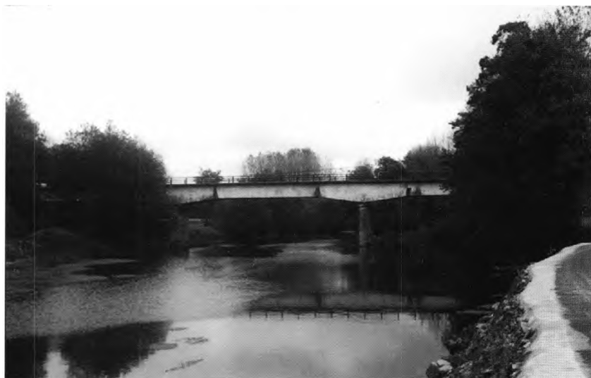
FIGURA 10 - Um antigo local de travessia do rio Águeda, junto a Óis da Ribeira
