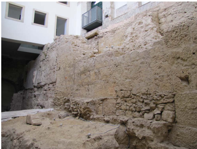
Figura 2. Face sul do post scaenium do teatro, a grande estrutura de suporte tardoz da fachada cénica.
