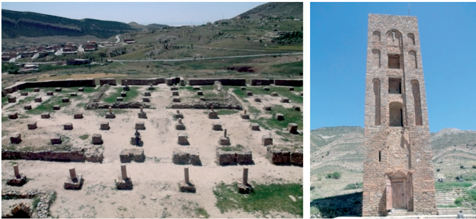
Fig. 4 - Etat actuel de la grande mosquée; façade sud du minaret. Source: Cliché de l'auteur, 2014
