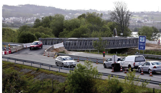
Fot. 7 - Aspeto da ponte militar fixa (MABEY) instalada pela Engenharia Militar, nas imediações de Montemor-o-Velho (Fonte: Fotografia gentilmente cedida pelo EME).
