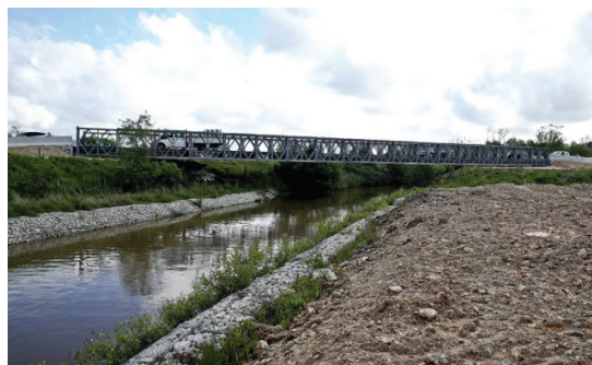
Fot. 8 - Vista geral da ponte militar fixa (MABEY) instalada pela Engenharia Militar, junto a Montemor-o-Velho (Fonte: Fotografia gentilmente cedida pelo EME).
