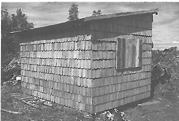
Fot. 10 - Pormenor da Fot.11, mostrando o revestimento das paredes do barracão, a "tejuela"
