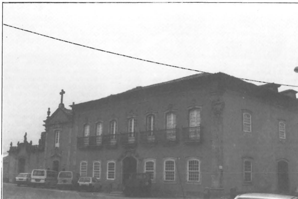
Fot. 15 - Casa do Benfeito (1995)
