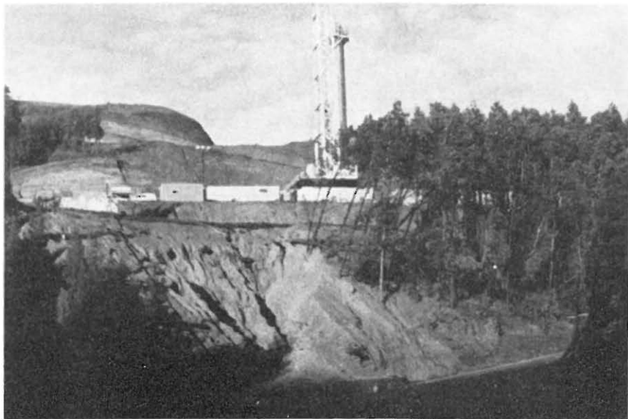
FOT. 3 — Área do furo e torre de perfuração geotérmica. Em primeiro plano, o leito da ribeira para onde foram lançados milhares de metros cúbicos de solo arável juntamente com árvores. Os ravinamentos são bem visíveis nesta fotografia tirada após as primeiras chuvas de Outubro de 1989.
