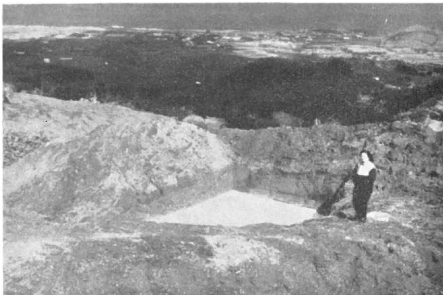
FOT. 1 — Depósitos de decantação da bentonite. Escavados no solo sem qualquer revestimento, permitem assim a sua infiltração e a contaminação das nascentes.
