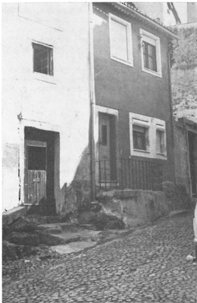
FOR. 9 — Pormenor da construção na Rua do Salvador. É de salientar que as casas assentam directamente sobre as formações calcárias (1982).
