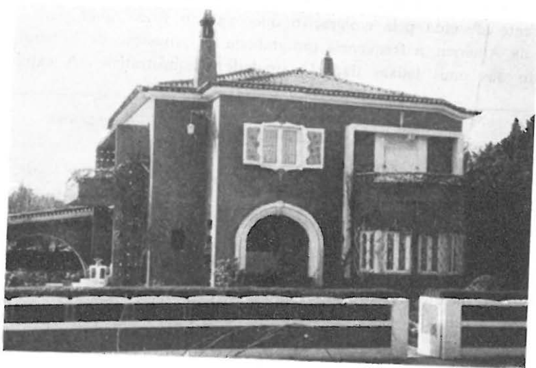
For. 1 — Residência de um armazenista de ouro construída em Vilamar no início da década de cinquenta.
