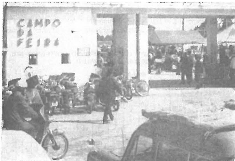
Fot. 2—Entrada do recinto da feira.
