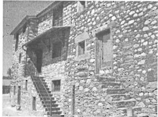
Foto 5 Imóvel particular em Janeiro de Cima (Fundão, 2006), após intervenção exterior com apoio do PAX Fonte: Paulo Carvalho
