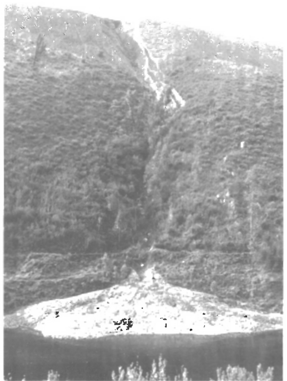
Fot. 3 - Forma torrencial de pormenor na margem esquerda do Rio Vouga. Trata-se de uma ravina originada pela concentração da escorrência a partir de um ponto num aterro preparado para a construção do Itinerário Principal nº 5 (IP 5). Fotografia gentilmente cedida pelo Dr. Enio Semedo, de Aveiro.
