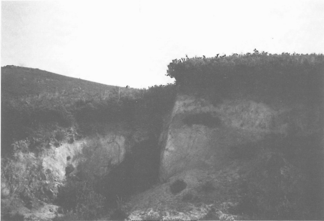
Fot. 5 - Detalhe de um bloco de granito alterado que sofreu abatimento, a montante da cicatriz principal.
