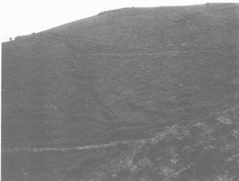
Fot. 3 - Fendas de descompressão resultantes do fluxo de detritos.
