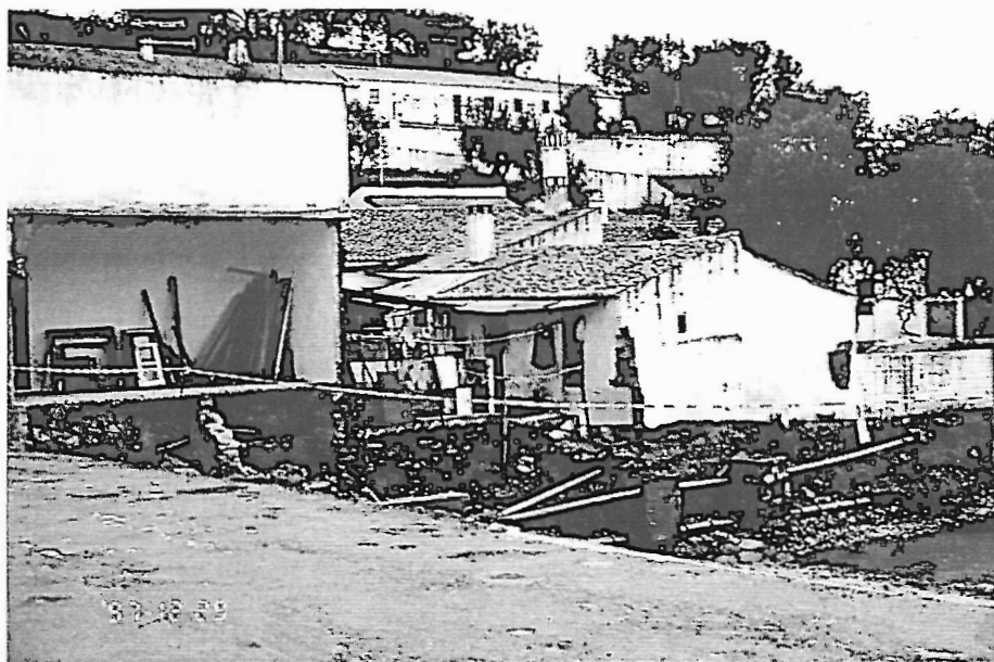
Fot. 6 - Garvão – casas destruídas pela cheia junto ao canal igualmente afectado. Fotografia tirada de cima da ponte, também em parte destruída.
