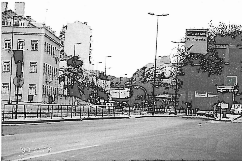
Fot. 1 - Aspecto da parte terminal do canal de escoamento da “torrente” de Alcântara.
