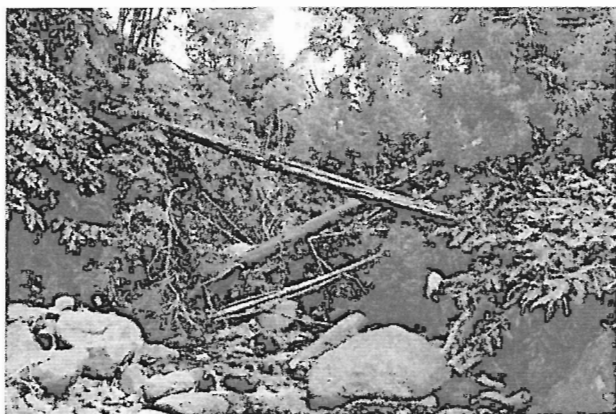
Fot. 13 - Deslizamento provocado pelo trabalho de sapa, na Ribeira dos Bispos
