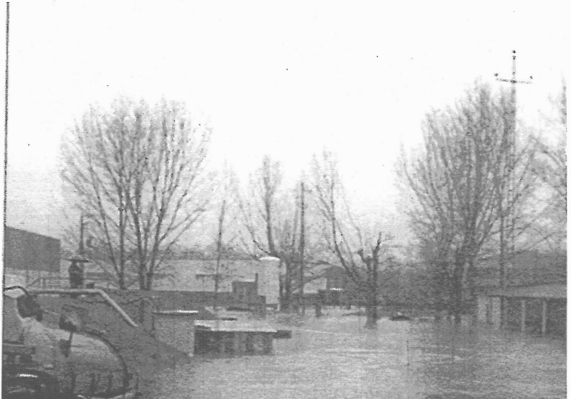
Foto 4 - Parque Industrial de Padim da Graça
