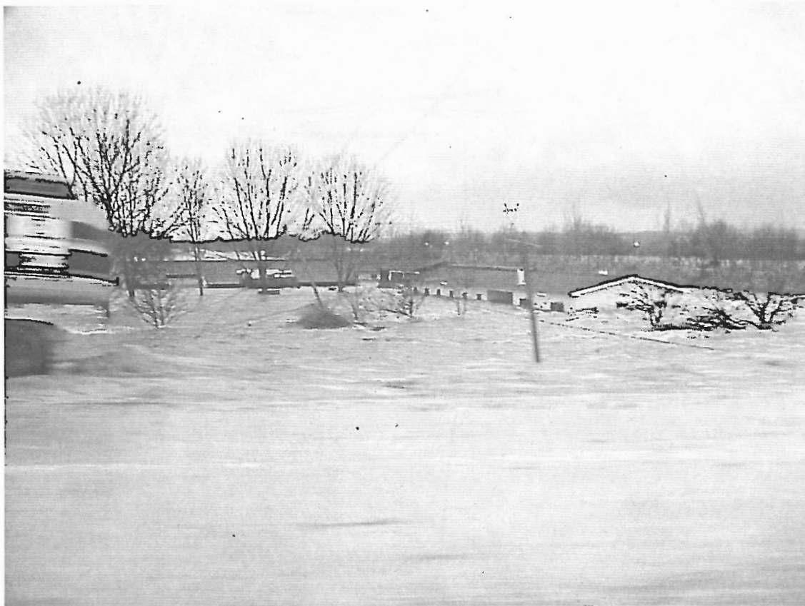
Foto 17 – Ruptura no dique esquerdo do Canal Principal (ao fundo, à direita, na foto), junto aos edifícios de uma quinta agrícola em Ribeira de Frades, a introduzir uma torrente de água. Em primeiro plano, na faixa da auto-estrada A1 está uma grua a descarregar pedras para proteger o talude da A1 (foto de P. Cunha, 27/01/2001, pelas 16h30m).
