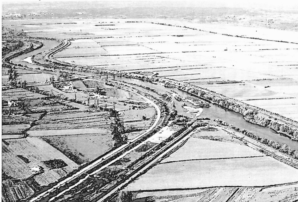
Foto 4 – Vista aérea oblíqua do Canal Principal do Mondego, entre a confluência com o Leito Periférico Esquerdo e o açude de Formoselha (foto de P. Cunha, a 6/11/1998). Notar as ilhas com árvores no local onde se fazia extracção de areia.
