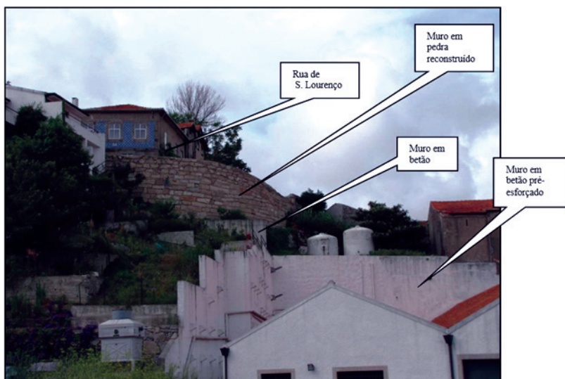
Fot. 8 - Muro em betão armado e do muro em pedra e a antiga muralha do Castelo de Gaia desapareceu... ! (Salvador Almeida, 2009).
