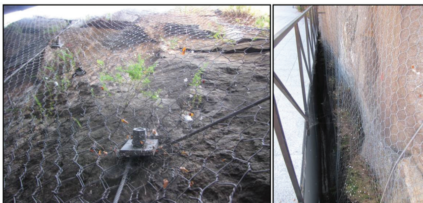
Fot. 11 - Pregagens do talude em granito no interior da Calém (Salvador Almeida). Photo 11 - Nailing the granite slope within the Calém (Salvador Almeida).
