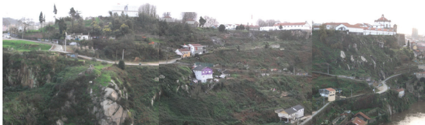
Fot. 17, 18 e 19 - Escarpa da Serra do Pilar Dezembro 2015 (Salvador Almeida).
