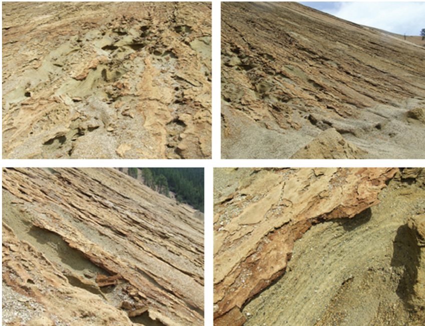
Fig. 5 - Estado em que se encontra a escombreira do Cabeço do Pião. Evidencia claramente ausência de manutenção e concomitantemente contribui para o aumento da instabilidade da escombreira.
