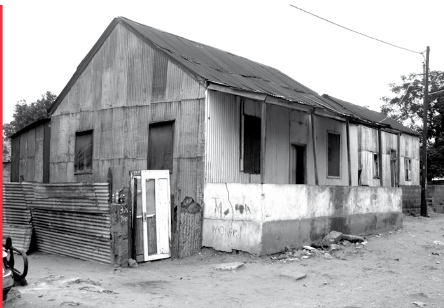
Casa de madeira e zinco, 2013.
