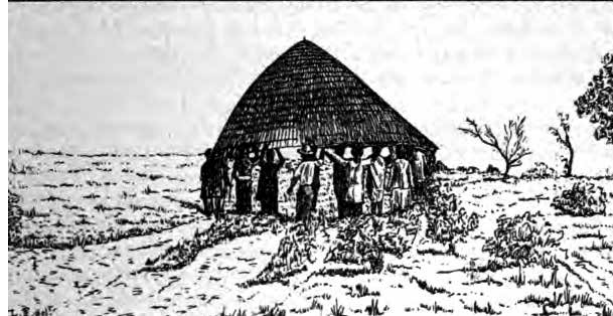
Execução da cobertura cónica da casa tradicional cilíndrica dos Mpfumu.
