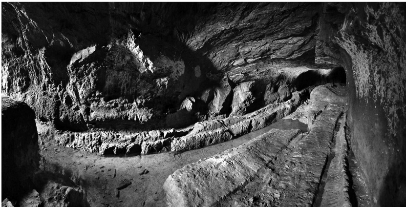
FIG. 11 – Galeria do Pilar, boca de salida, con restos de las rodadas dejadas por los carruajes que transportaban el mineral y el estéril y el canal de desagüe (Foto: Nuno Farinha).
