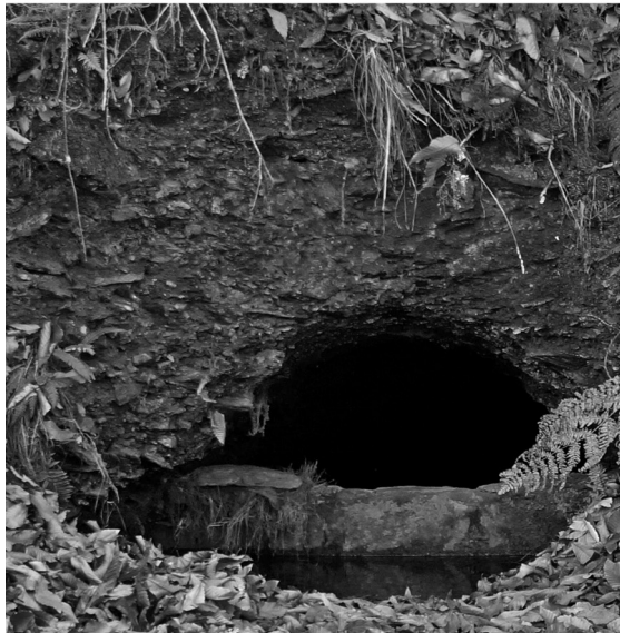
FIG.12 – Galeria do Texugo, boca de salida practicada en los estériles procedentes de la Galeria do Pilar y detalle de la misma donde se aprecia la composición de esos estériles (FOTO: JSP).
