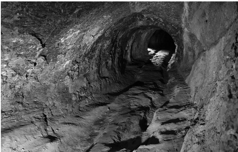
FIG. 7 – Galeria dos Alargamentos, con las típicas rodadas dejadas por los carruajes que transportaban el mineral y los estériles (Foto: Nuno Farinha).
