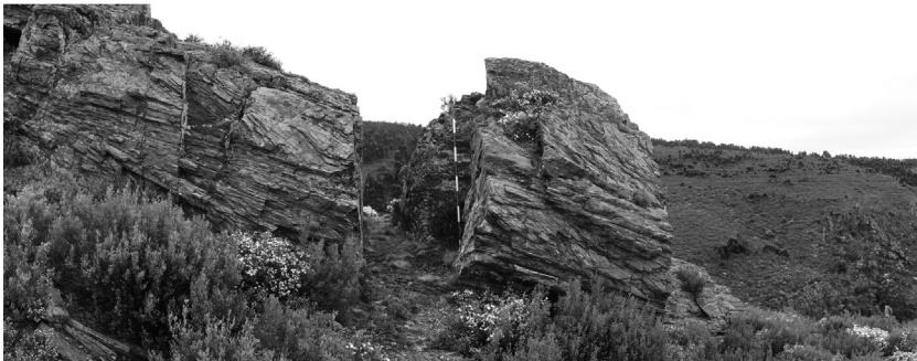
FIG. 20 – Fragas das Covas . Detalle del corte en la roca realizado para dar paso al canal de abastecimiento c-2 (Foto: JSP).
