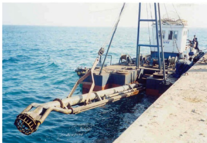
a) Equipamento de dragagem.
