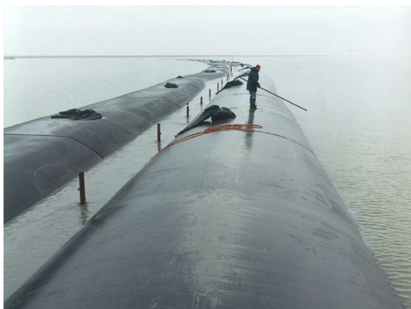
Figura 7.12 - Exemplo de aplicação de geotubos como quebramar.
