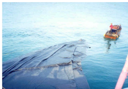
b) Transporte do tubo de geotêxtil.
