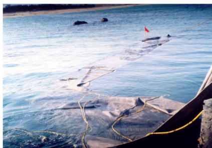
c) Colocação do tubo em posição.
