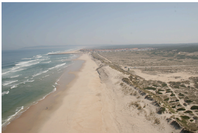
Figura 7.15 - Perspetiva do cordão dunar da Leirosa, com a localidade ao fundo e a zona intervencionada para proteção da câmara de carga do emissário situada sensivelmente a meio do trecho (adaptada de Voorde et al. , 2007a,b; Antunes do Carmo et al. , 2009a).
