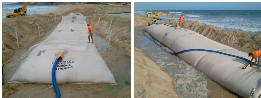
Figura 7.14 - Fases de preparação e enchimento de geotubos para aplicações longitudinalmente (uma ou duas linhas em paralelo), ou sobrepostos em camadas.
