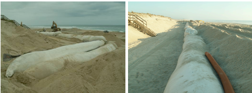
b) Instalação em camadas na base da barreira de proteção.
