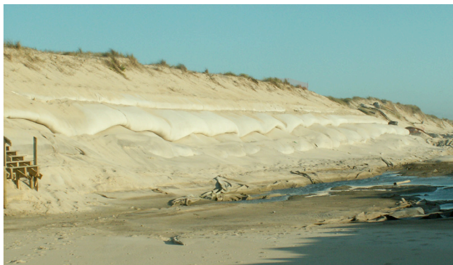
Figura 7.13 - Instalação de geocontentores em barreiras de proteção de um sistema dunar.
