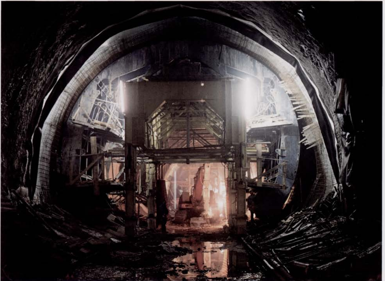
Metropolitano, túnel norte. Secção escavada e revestimento Metro, north tunnel. Excavated section and lining
