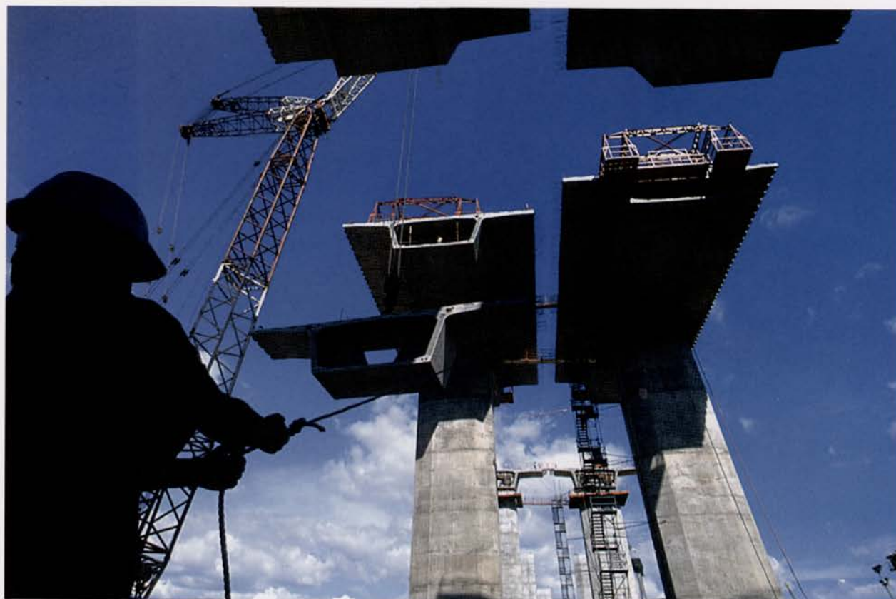
Viaduto Expo. Montagem de aduelas Expo viaduct. Installation of the arches
