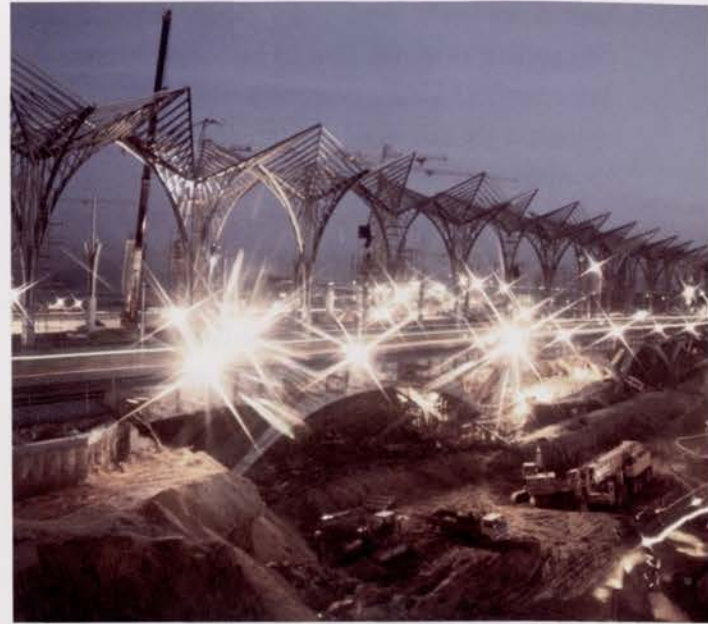
Gare ferroviária, escavação da segunda fase Railway station: excavation during phase two
