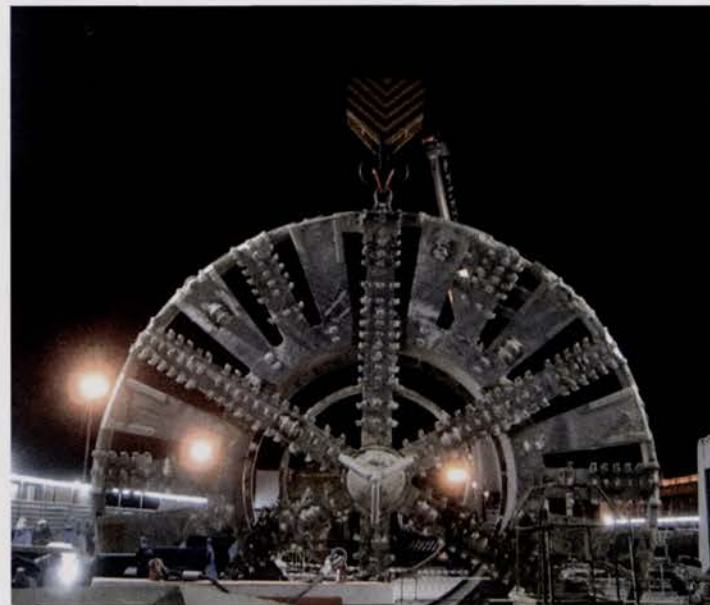
Escudo: içamento da roda de corte Shield: hoisting of cutting wheel
