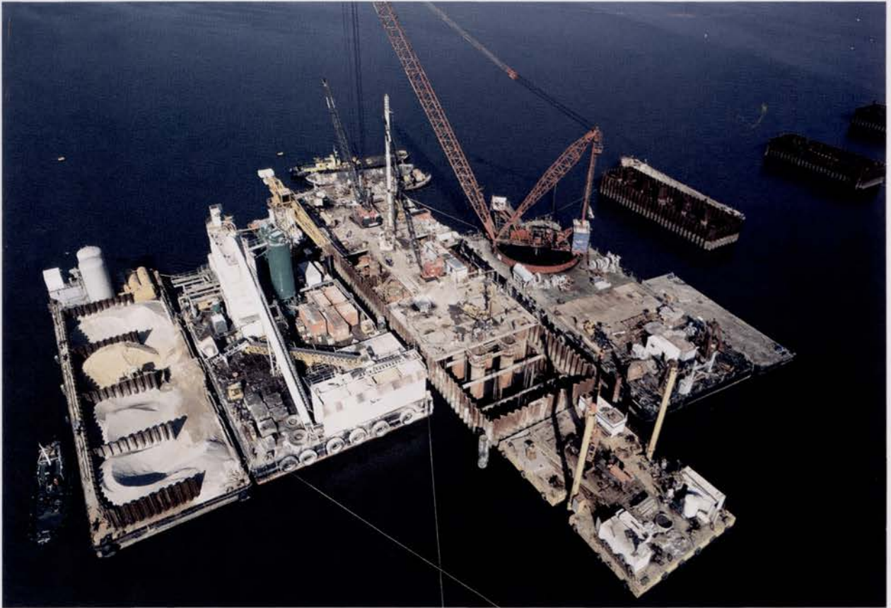
Ponte principal, torre sul, ensecadeira. Execução de estaca escavada: equipamentos de escavação, montagem de armaduras e central de betão
