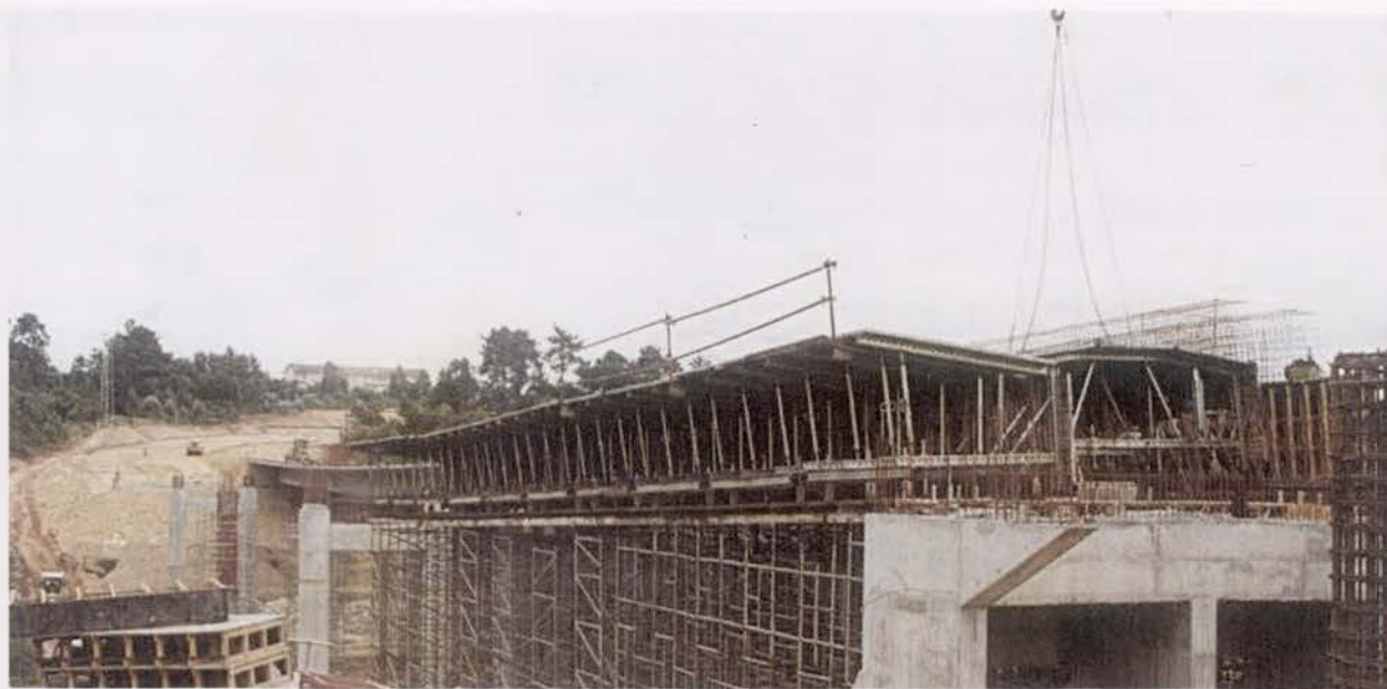
Cofragem deslizante Slipforms
