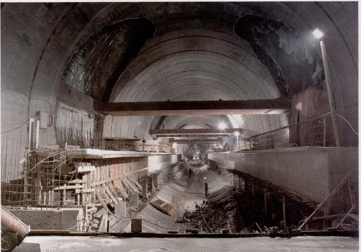
Estação poente: betonagem das estruturas internas West station: concreting of internal structures
