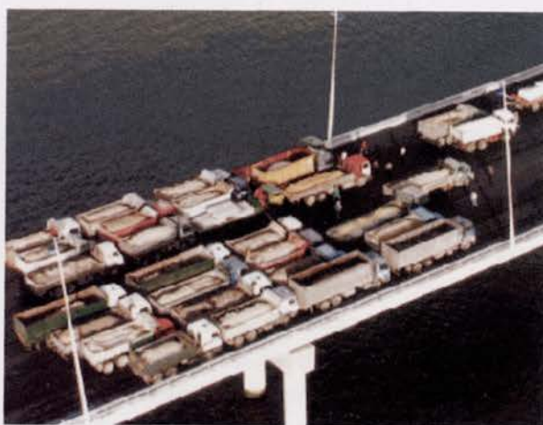
Ensaio de carga do viaduto sul South viaduct load test
