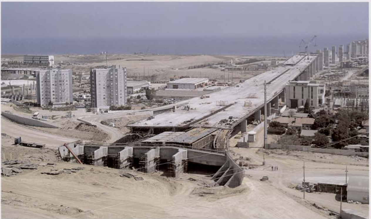
Viaduto Expo Expo viaduct
