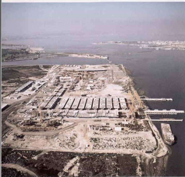
Viaduto central. Estaleiro de pré-fabricação Central viaduct. Pre-fabrication yard
