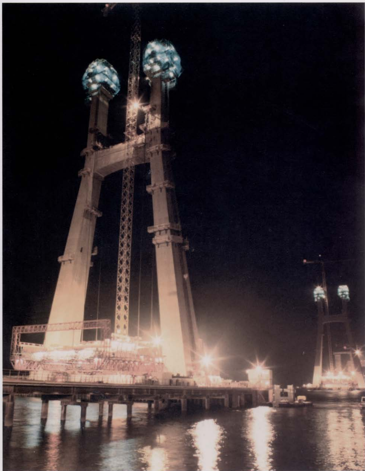
Ponte principal, torre norte. Construção do tabuleiro do vão central Main bridge, North tower. Construction of central span deck
