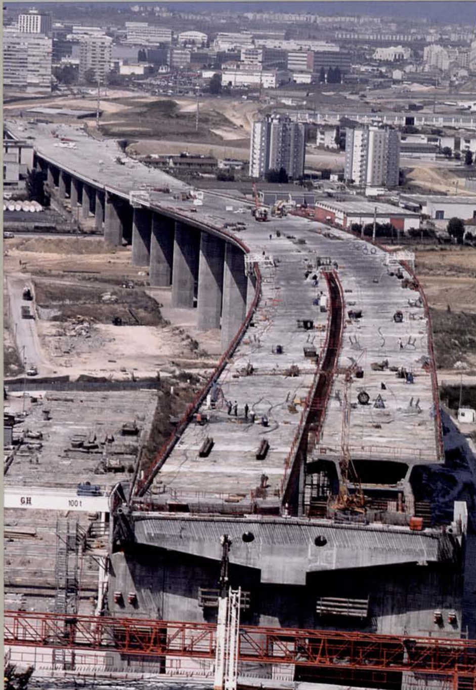
Viaduto Expo. Conclusão da montagem das aduelas do tabuleiro Expo viaduct. Completing installation of deck arches
