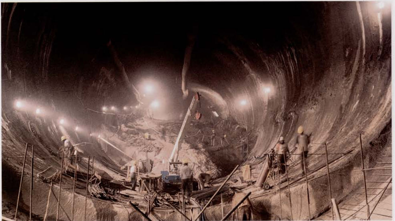
Estação nascente: fase de betonagem East station: concreting phase
