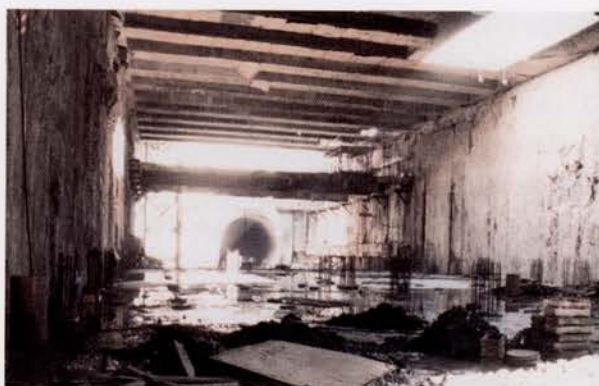
Escavação e betonagem da estação do Cais do Sodré executada a céu aberto
