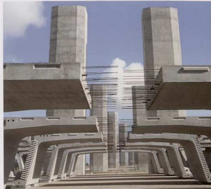
Viaduto Expo. Estocagem de aduelas pré-fabricadas, junto aos pilares Expo viaduct. Storing prefabricated arches next to piers
