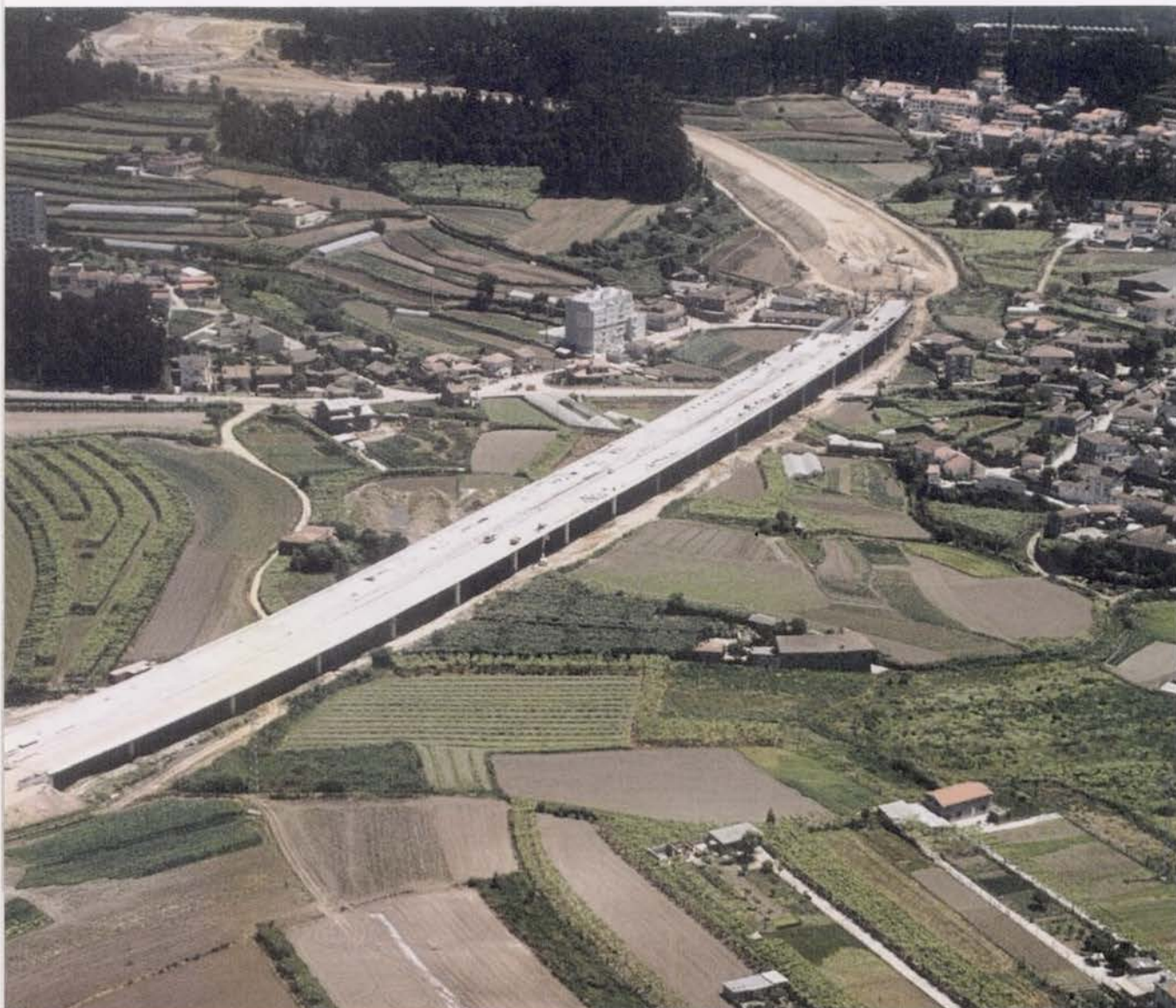
Viaduto de Ramalde - IC 29 via rápida de Gondomar, obras de arte individualizadas Ramalde Viaduct - IC 29 Gondomar expressway, individualized overpasses and underpasses
