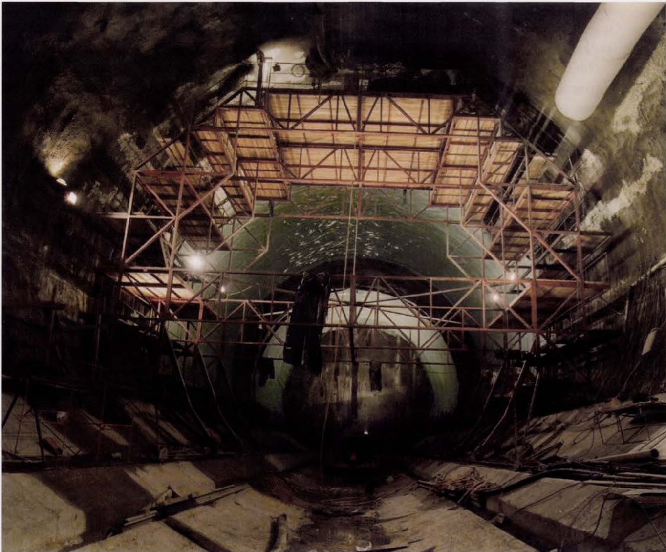
Impermeabilização e construção do revestimento secundário na estação nascente da Baixa-Chiado Impermeabilization and secondary lining construction for the east station of Baixa-Chiado
