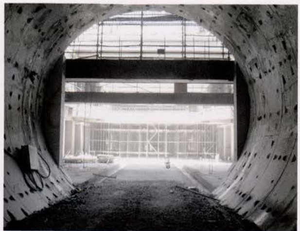
Estação de Santa Apolónia: emboquilhamento Santa Apolónia station: tunnel entrance
