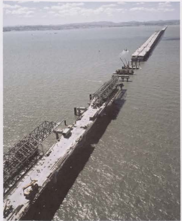
Viaduto sul. Construção do tabuleiro com treliças móveis de cimbra aérea
