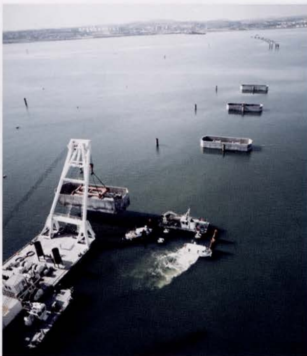
Viaduto central. Montagem de caixões dos maciços de encabeçamento das estacas Central viaduct. Installing box piles
