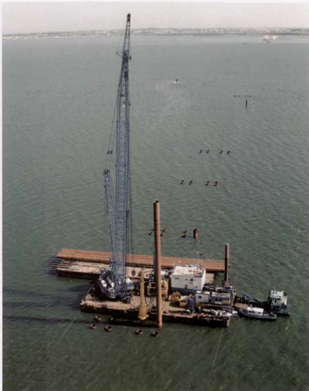
Cravação de estacas – viaduto central Driving piles – central viaduct
