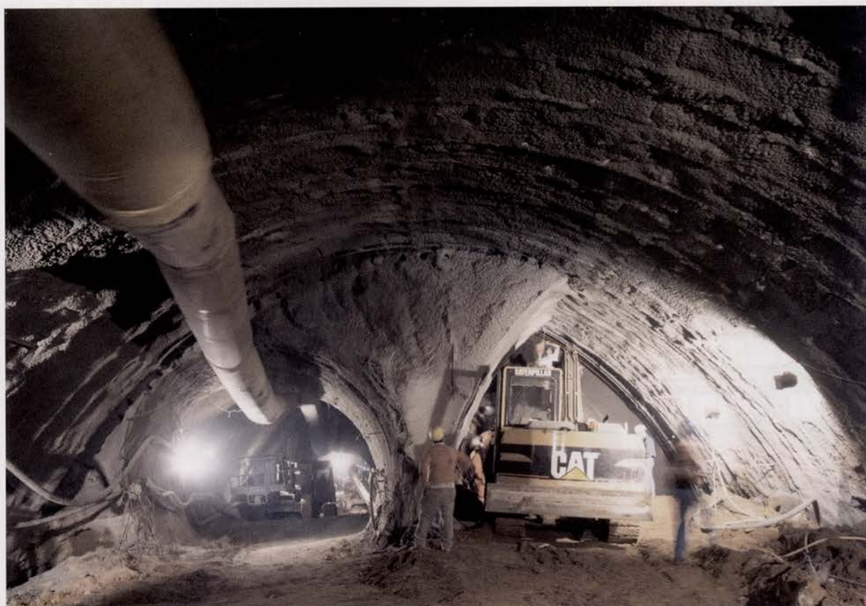
Vista dos trabalhos de escavação nas secções 1, 2 e 3 da estação poente
