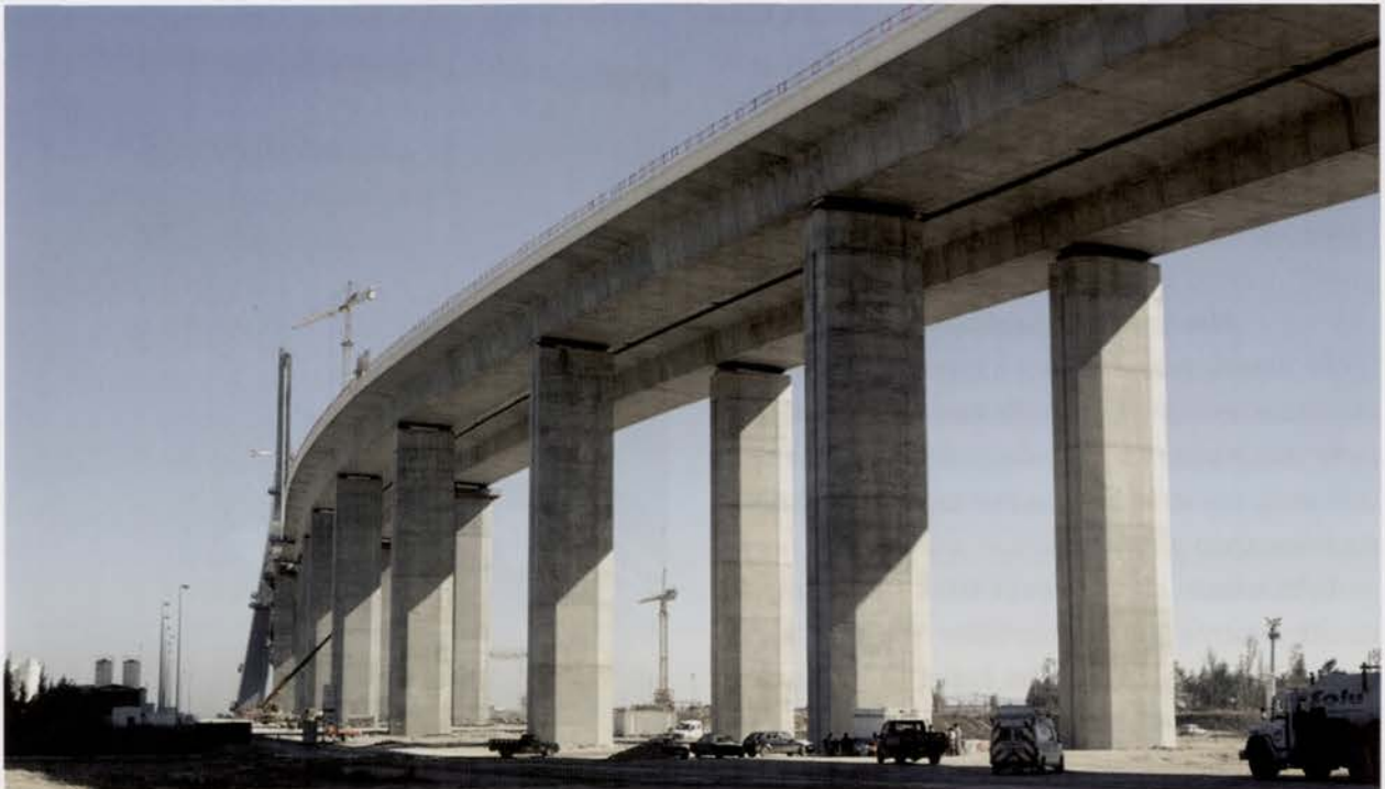
Viaduto Expo Expo viaduct
