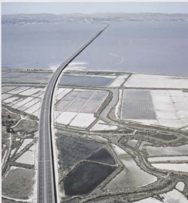
Viaduto sul, vista geral, em primeiro plano a região das salinas e ao fundo o Banco do Samouco
