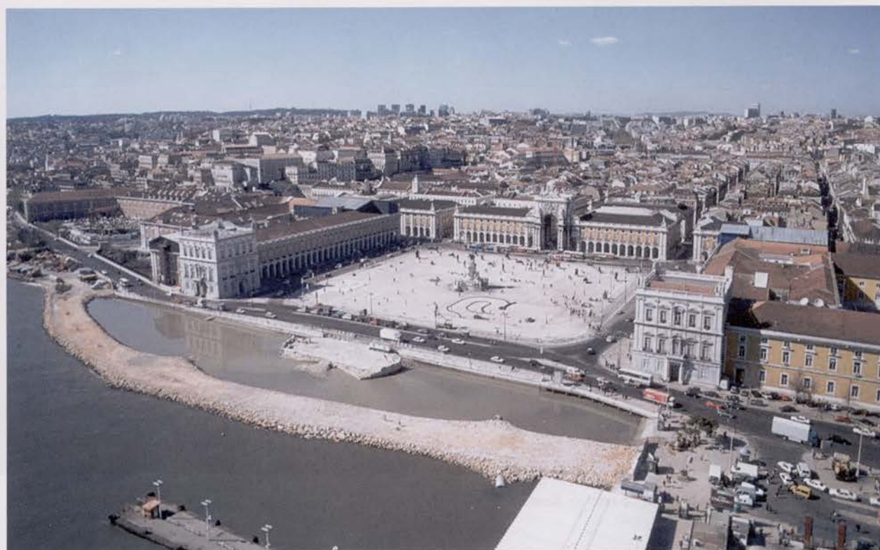
Aterro no Cais das Colunas já concluído Cais das Colunas embankment concluded
