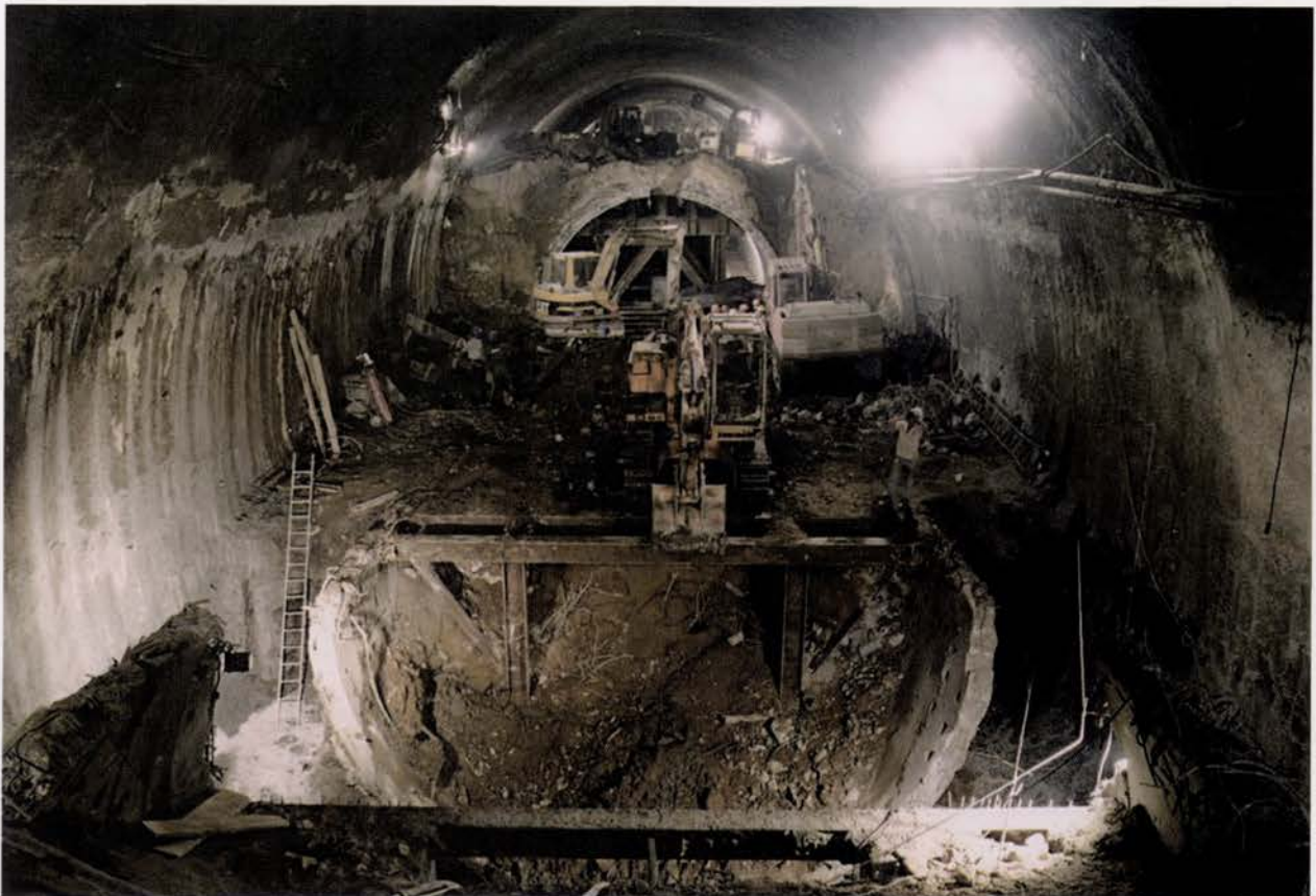
Estação poente mostrando as diversas fases de escavação West station showing the diverse phases of the excavation
