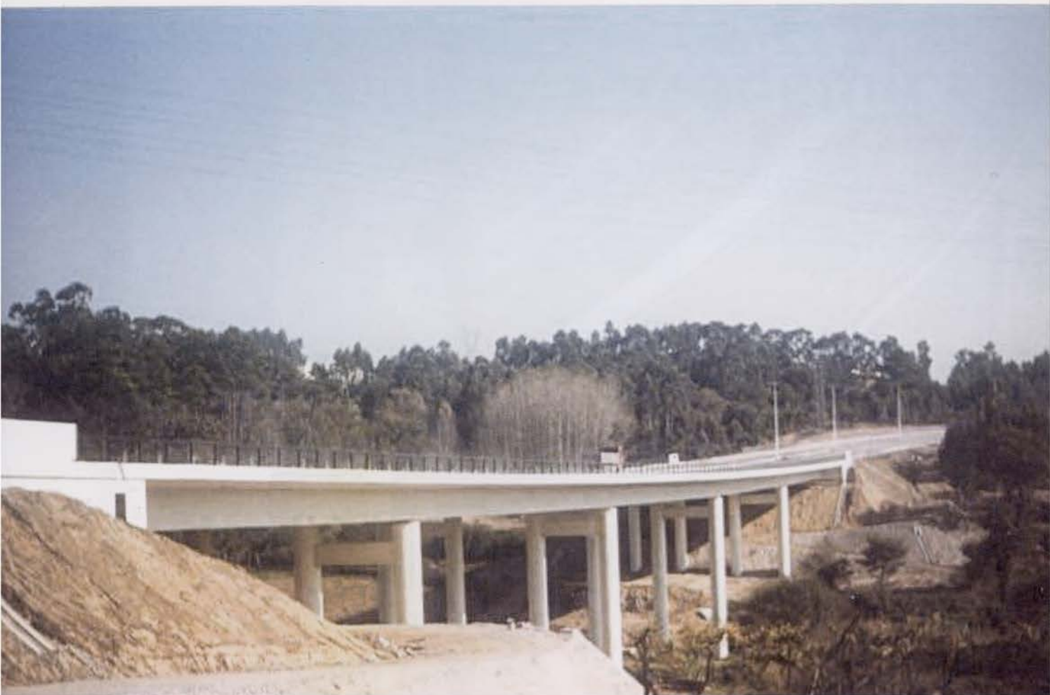
Viaduto sobre o rio Tinto – IC 29, da via rápida de Gondomar Viaduct across Tinto River – IC 29, Gondomar expressway
