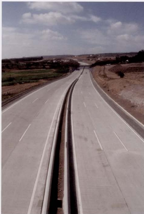
Troço Torres Vedras-Bombarral, concluída Torres Vedras-Bombarral section, completed
