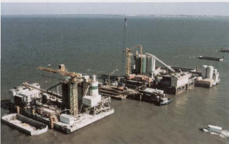
Centrais de betão ao lado dos maciços de encabeçamento Concrete batching plants next to pier groups
