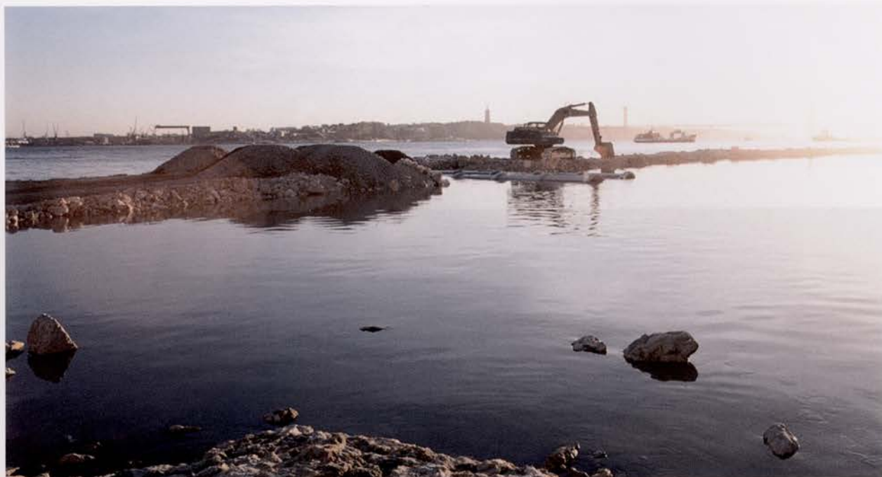
Aterro no Cais das Colunas em fase de construção Cais das Colunas embankment in construction phase
