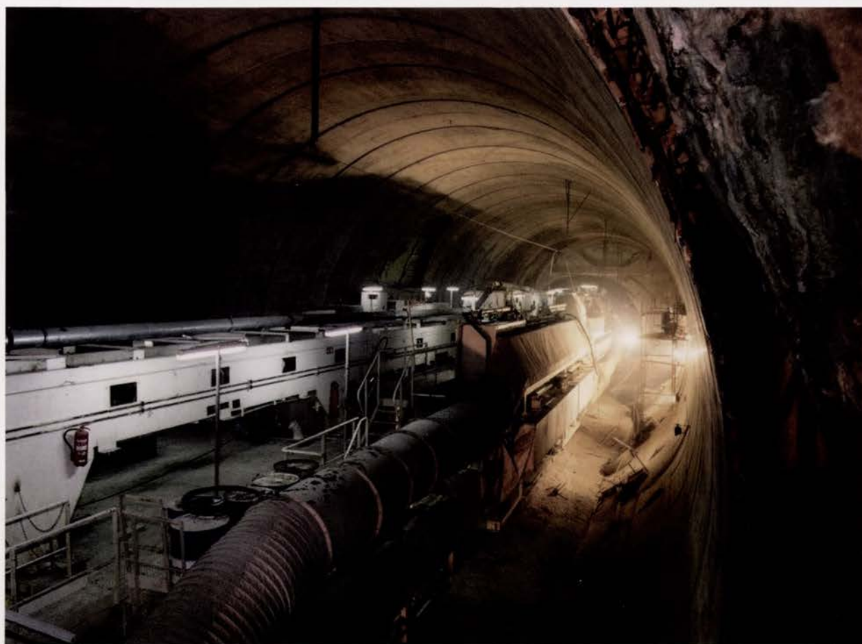
Vista do back up no início da construção do túnel Back up view for the initial construction phase of the tunnel
