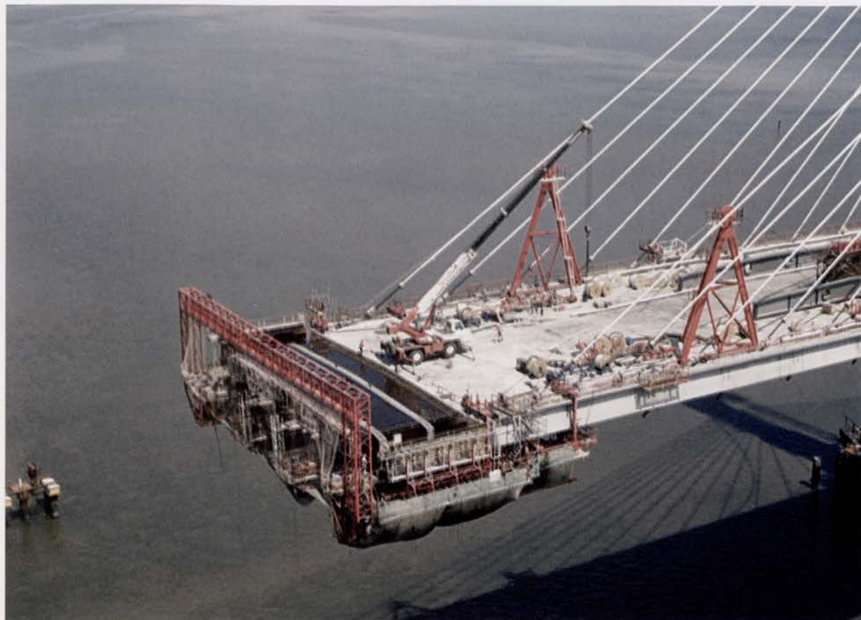
Ponte principal - execução do tabuleiro sustentado pelos tirantes Main bridge - building the cable-stayed deck
