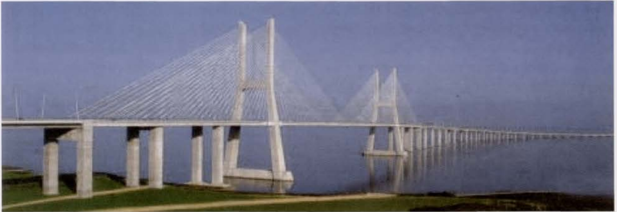
Estrutura atirantada por cabos da Ponte Vasco da Gama Cable-stayed component of the Vasco da Gama Bridge
