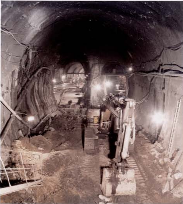
Escavação do ramal de inversão Excavation of the annex structure
