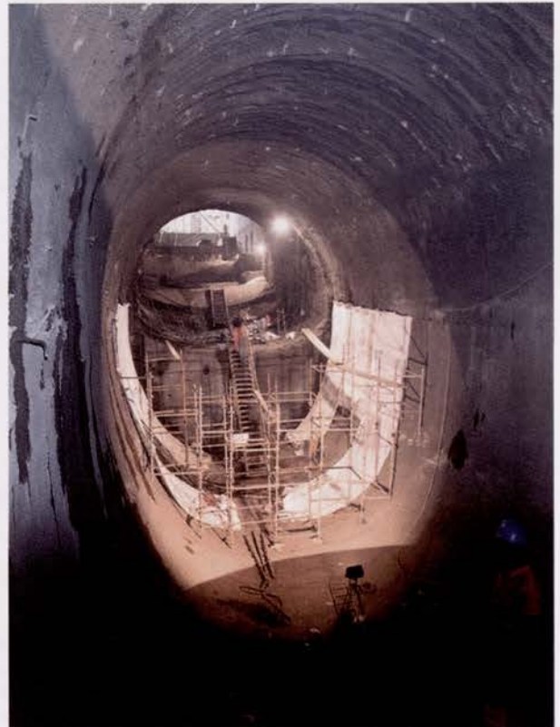
Acesso da Rua do Crucifixo: betonagem do encontro com a estação Rua do Crucifixo access shaft: concreting at station point
