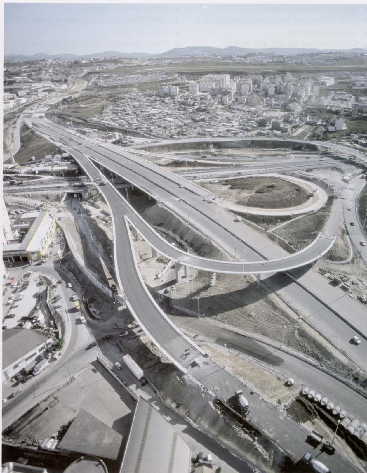
Nó de Sacavém, vista geral Sacavém Interchange, general view
