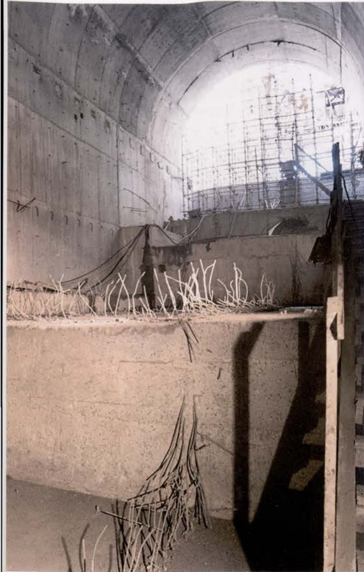
Acesso da Rua do Crucifixo: betonagem da embocadura Rua do Crucifixo access shaft: concreting of portal
