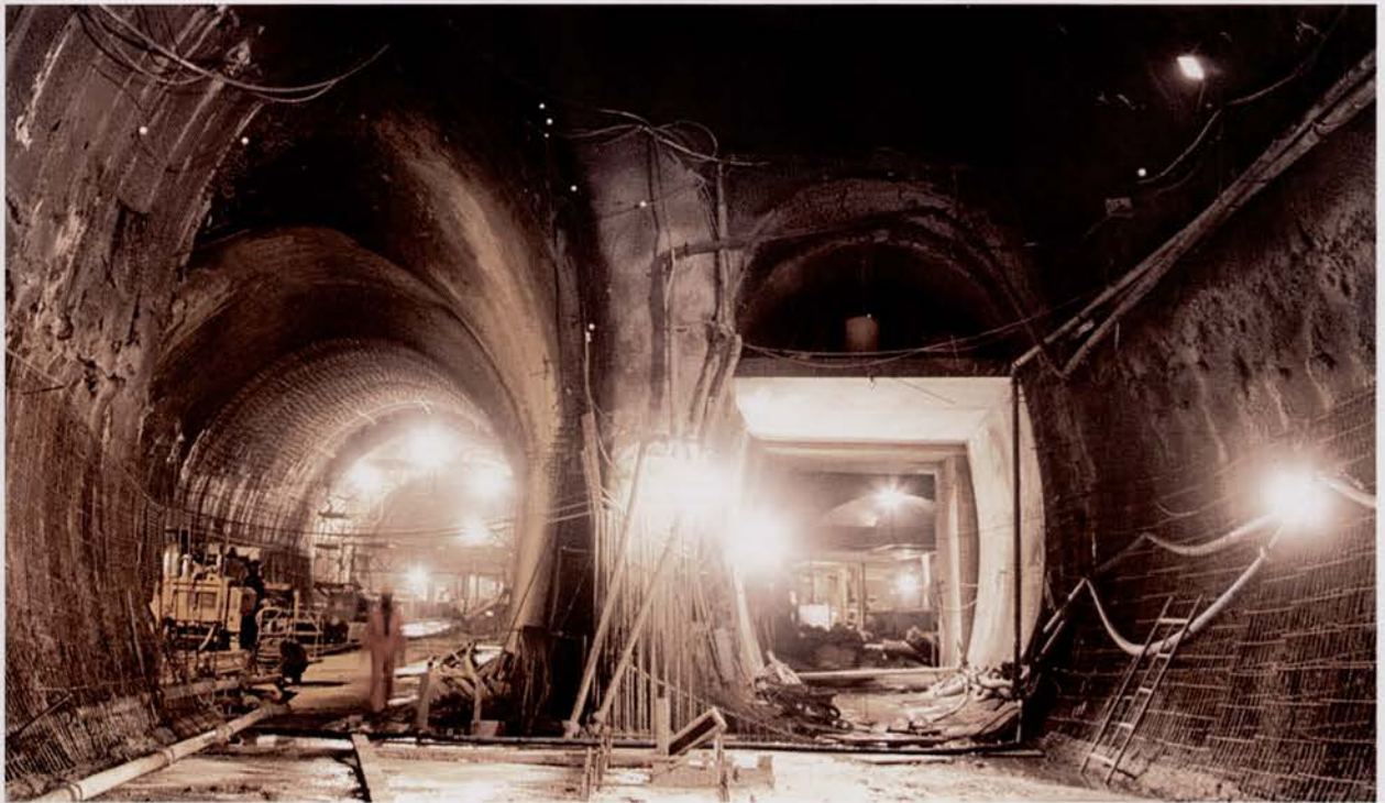
Baixa-Chiado – Área de ligação: execução da betonagem Baixa-Chiado – Connecting area: concreting
