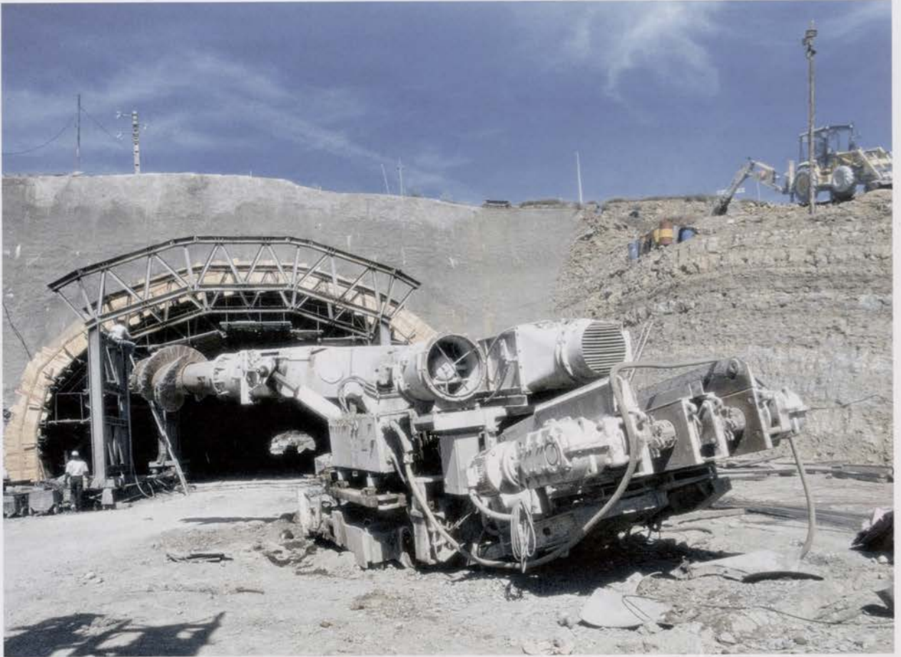
Fresadora Paurat, em trabalho de preparação do emboque sul Paurat shield, preparing south portal
