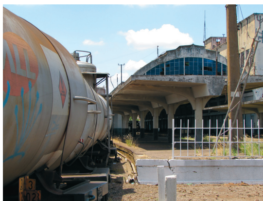
Fig. 2 - Transporte de combustível na Estação Ferroviária da EFNBO (Sérgio Losnak, 19/08/2014).
