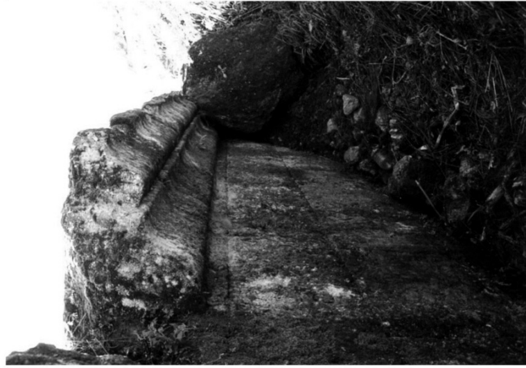
For. 3 - Cornija de coroamento nas traseiras do podium
