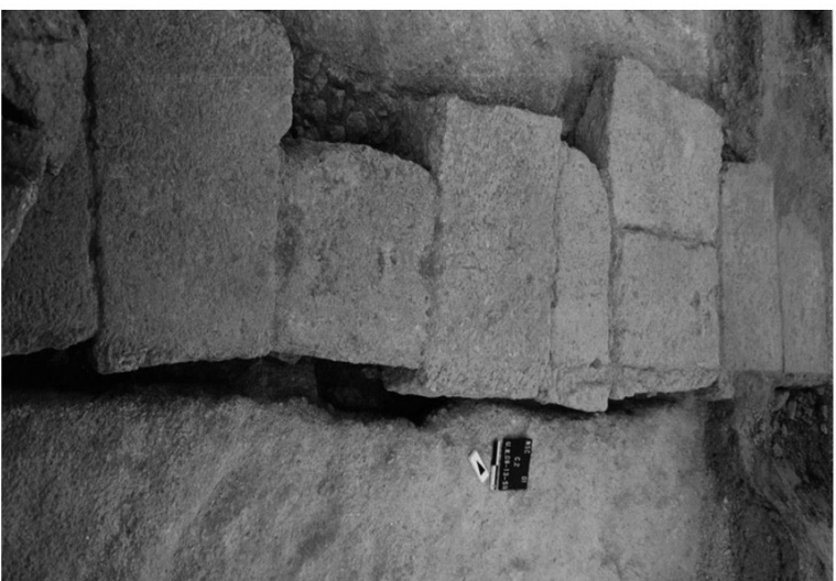
For. 6 - Pormenor de uma vau de fundação
