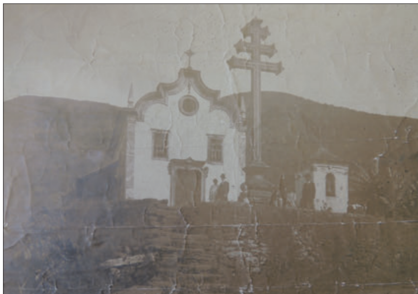
Fig. 4 Capela do Padre Faria, Ouro Preto, Minas Gerais, sem data, Arquivo Regional do IPHAN, Minas Gerais.
