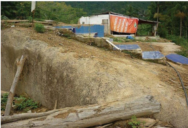
Figura 3 - Casa parcialmente destruída pelos movimentos complexos desencadeados nas vertentes da Serra da Prata de 2011
