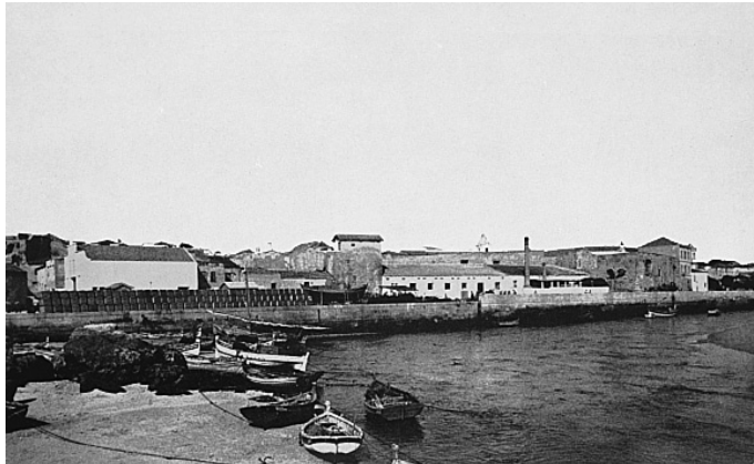
Fig. 7. Vista das Murallas de Lagos, antes das obras 74
