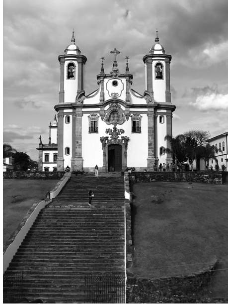
Fig. 2 - Capela da ordem 3ª de Nossa Senhora do Carmo, Ouro Preto (foto do autor)
